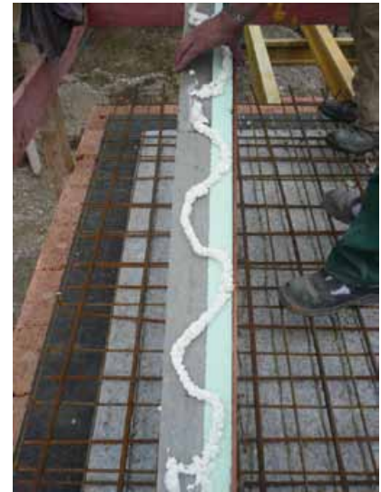
Auftrag „fingerdick“ in Schlangenlinien
