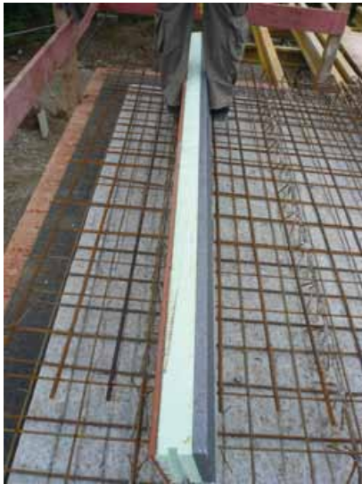
Vorbereiten der Elemente
