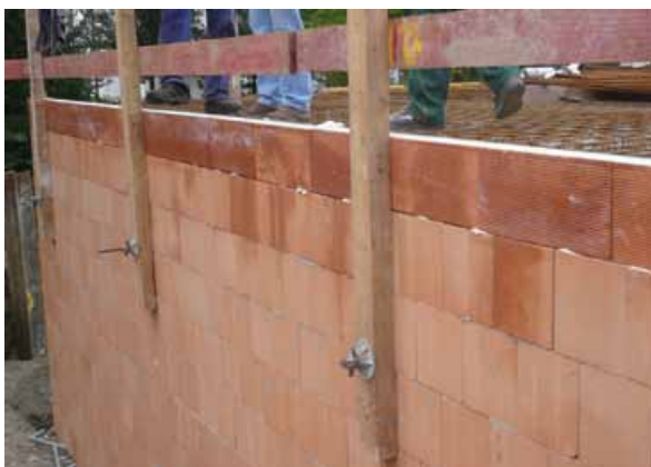
Deckenrandelemente fertig verlegt
