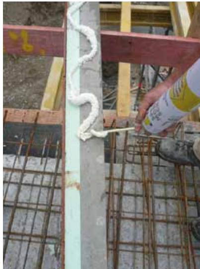
Auftragen des Spezial-PU-Schaumes
